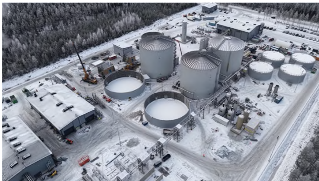
Nurmon laitoksen rakennusvaihe 23.1.2026. Etualalla jälkimädätyssäiliöt ja vasemmalla lämpölaitos sekä lannoitevalmisteen separointihalli. Kuva: Ramboll Finland.
